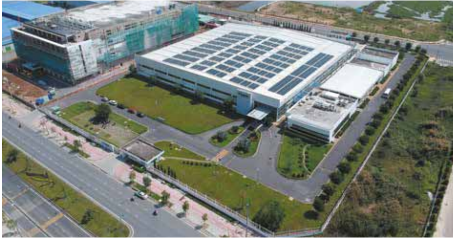
Installation de panneaux solaires sur une usine Schneider Electric au Vietnam.
