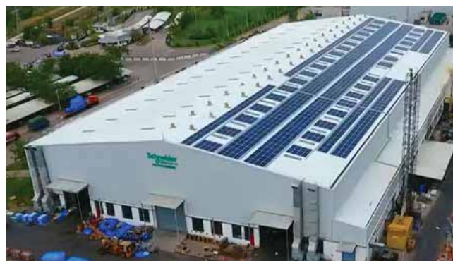
L'usine MVI & TBI de Schneider Electric en Inde génère environ 1 GWh par an d'énergie solaire sur site
